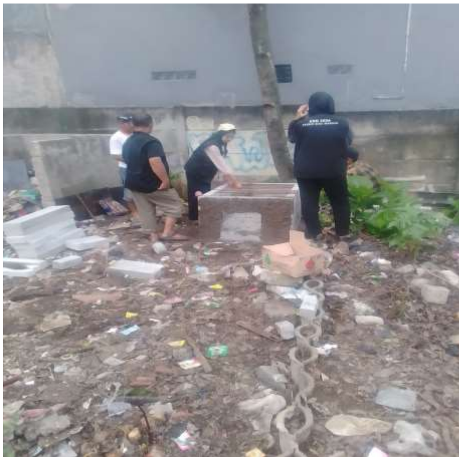
Gambar 1. Proses Pembangunan Insinerator
